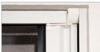
Profilerna kläms horisontalt. Montering utan skruv!
